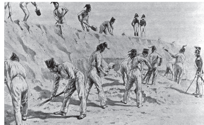
Budowa wałów twierdzy
