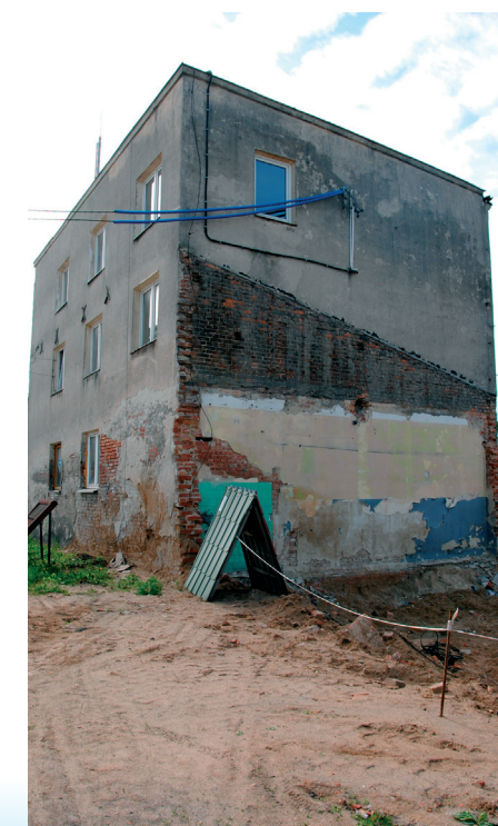
Zachodnia ściana młyna
