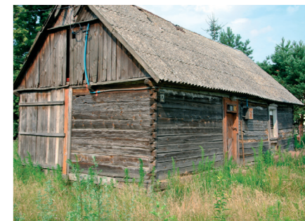
Stary dom pp Pawlaków przy ul. Nadbużańskiej
