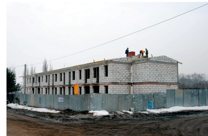
Budowa budynku socjalnego
