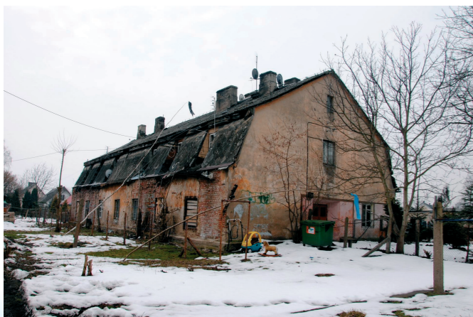
Budynek mieszkalny dawnego folwarku od wschodu
