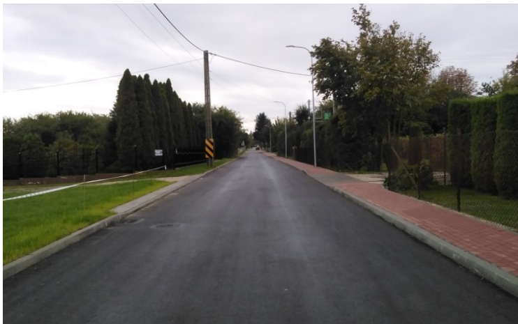
Fot 3. Przebudowa drogi w Wierzbicy
