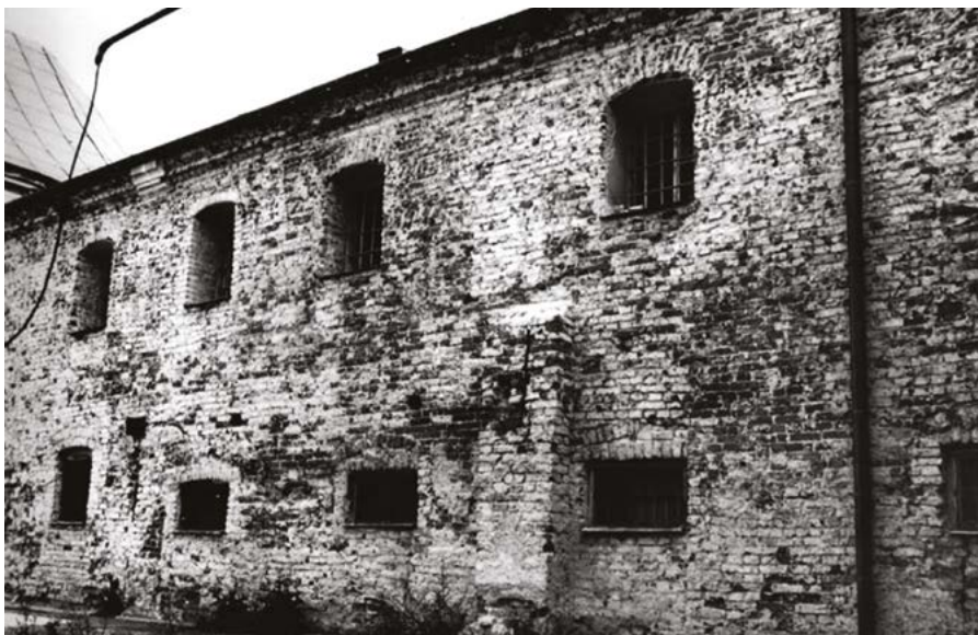
Więzienie w Pułtusk – widok od strony dziedzińca (zbiory IPN)
