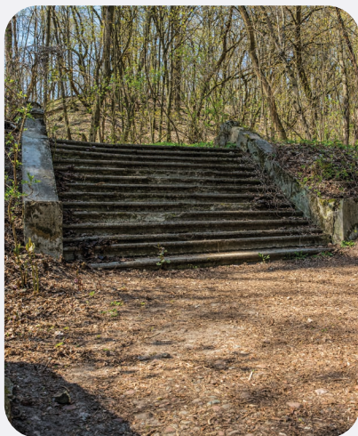
Schody do dworku wykonane w latach 20. XX w., fot. Agnieszka Woźniakowska
