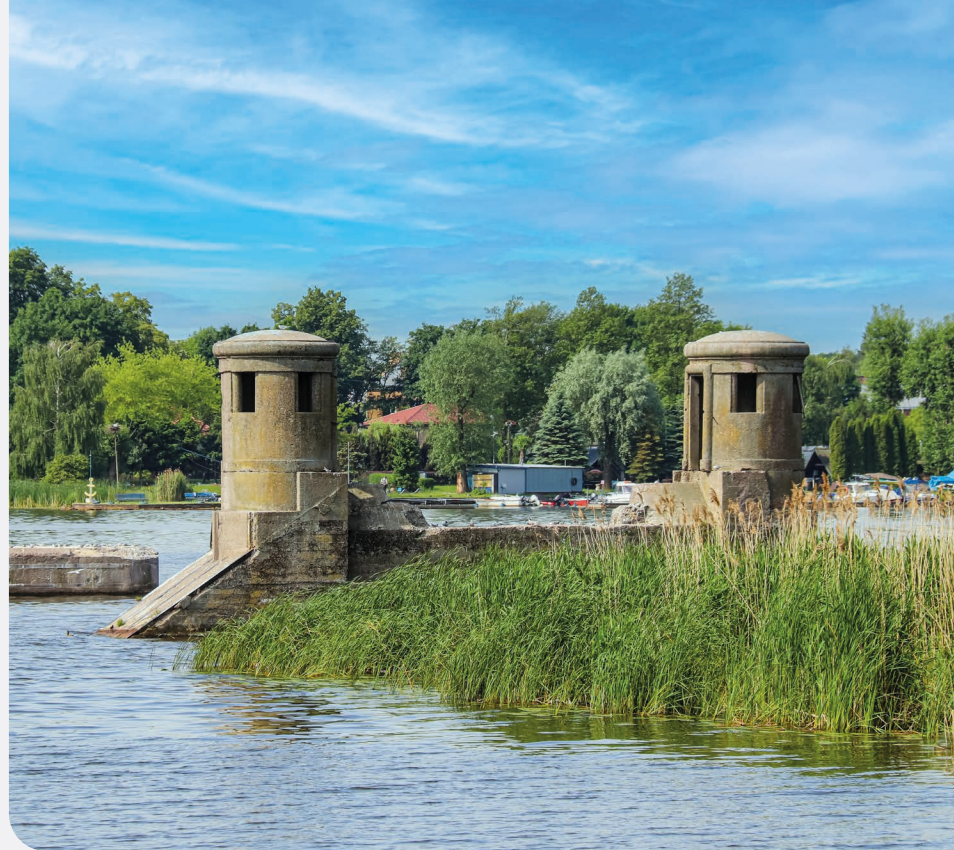
Pozostałości mostu niemieckiego z 1916 r., fot. Mirosław Pakuła
