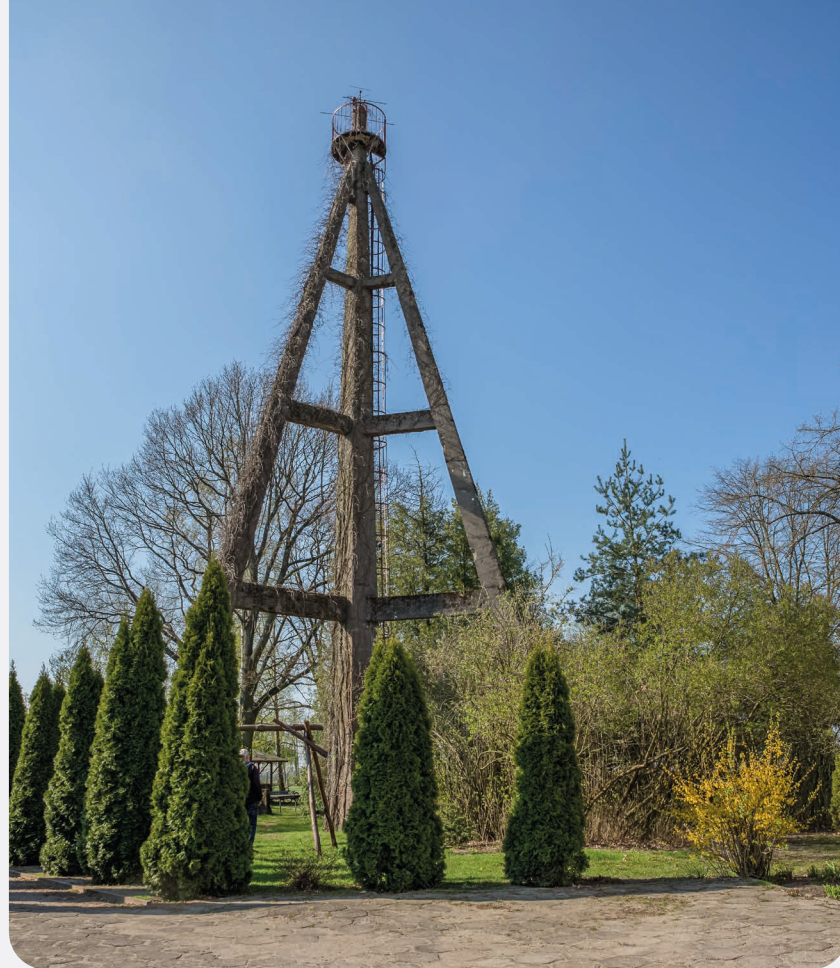
Wieża z 1936 r. pomocna przy badaniu instrumentów do pomiaru azymutu, fot. Agnieszka Woźniakowska
