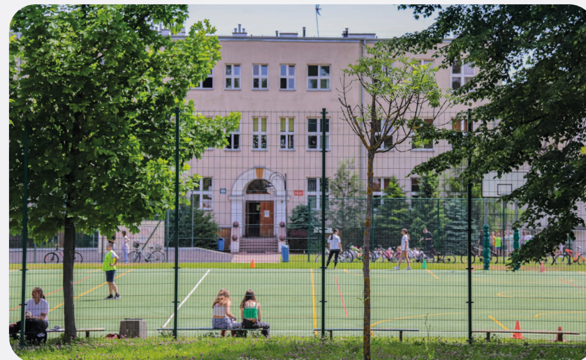
Widok od strony ulicy Pułtuskiej, pośrodku widoczne zachowane przedwojenne wejście do budynku, fot. Mirosław Pakula
