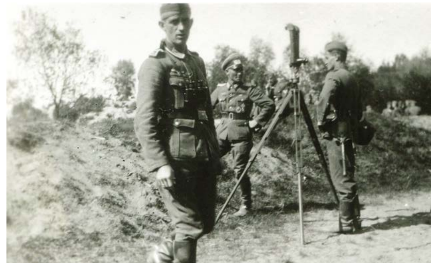
Nauka posługiwania się lornetą nożycową Scherenfernrohr 14 Z (S.F. 14 Z) na poligonie w Zegrzu. Układ soczewek w systemie peryskopowym pozwalał na obserwację pola bitwy bez wychylania się z okopu i narażania na ostrzał nieprzyjaciela. Na odwrocie widnieje napis, który po przetłumaczeniu brzmi: Mój dowódca plutonu por. Bettin. Zegrze 2 maja 1943 r.
