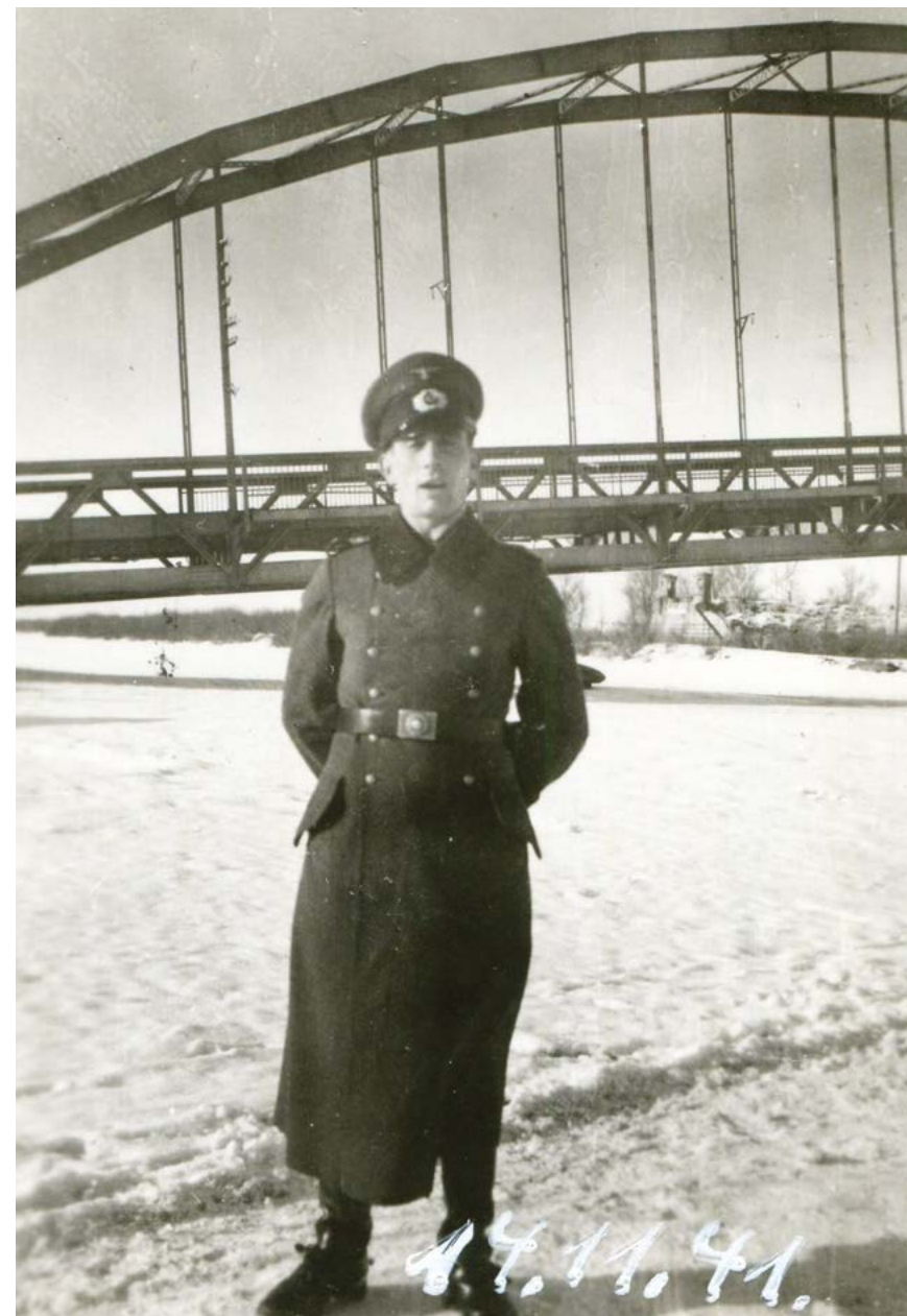
14 listopada 1941 r. niemiecki żołnierz sfotografował się na tle zwalonego przęsła od strony Zegrza. Silny mróz pozwolił mu stanąć na rzece skutej lodem. W głębi widać filar z wieżyczkami. Uwagę zwraca brak mostu znanego z poprzednich zdjęć.
