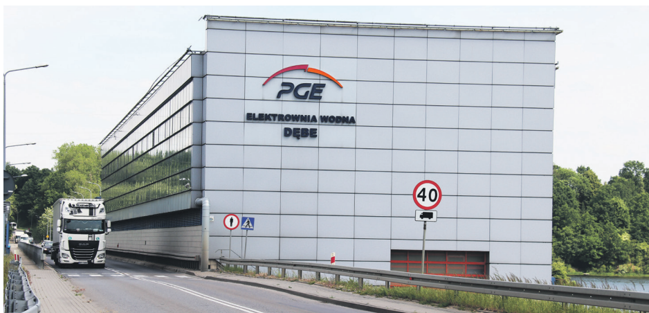
Elektrownia, część stopnia wodnego Dębe, w rzeczywistości znajduje się w Komornicy (fot. M. Pakuła)
