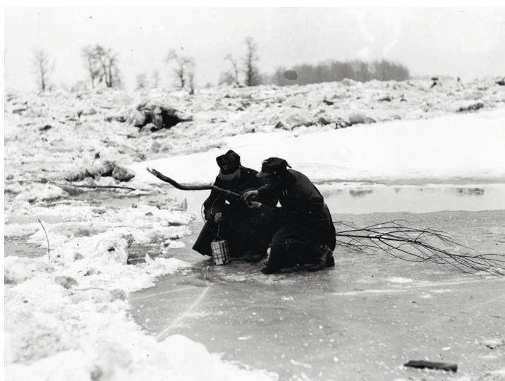
Saperzy przygotowujący ładunki do wysadzenia zatoru na Wiśle w okolicach Warszawy, 1929 r. (NAC)
