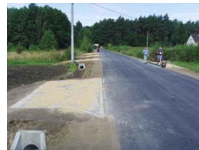
Przebudowa drogi gminnej w Woli Smolanej
