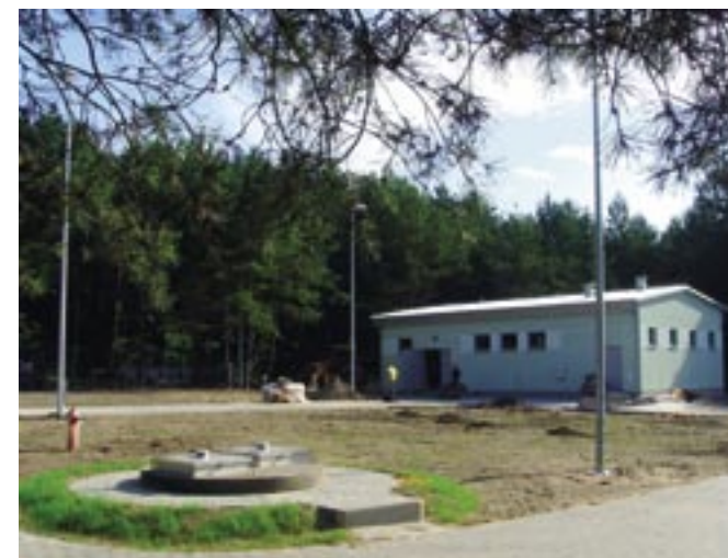
Modernizacja Stacji Uzdatniania Wody w Wierzbicy
