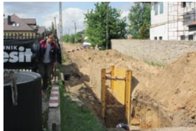
Budowa sieci kanalizacyjnej w ul. Spokojnej w Serocku
