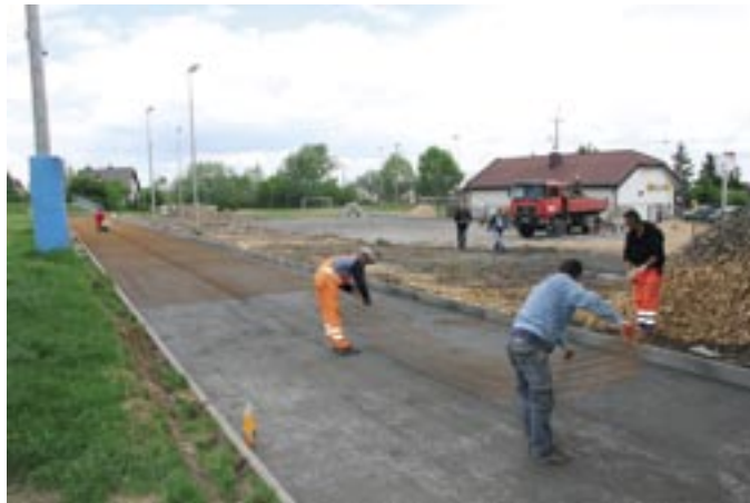
Budowa bieżni w ramach modernizacji stadionu miejskiego w Serocku
