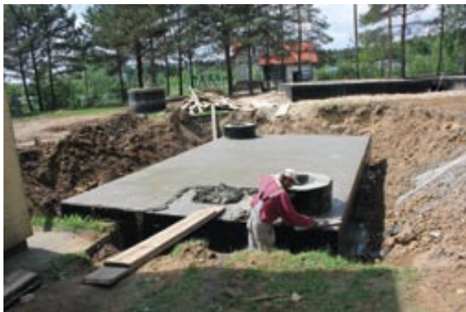
Modernizacja stacji uzdatniania wody w Wierzbicy
