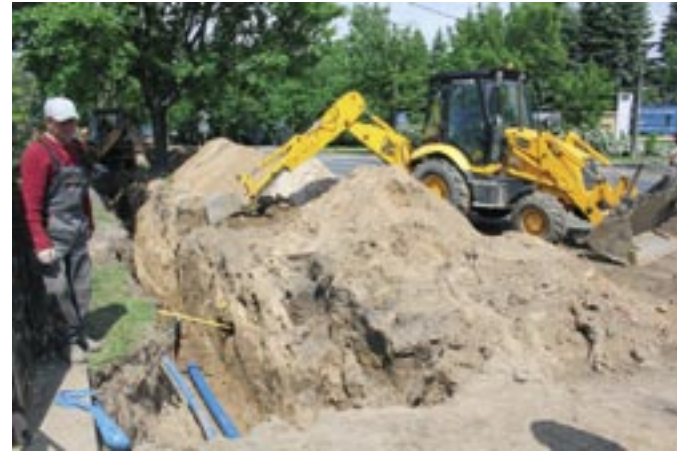
Budowa sieci wodociągowej Serock - Wierzbica
