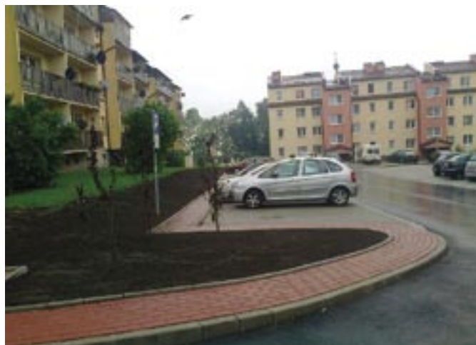
ul. Drewnowskiego w Zegrzu przebudowa drogi i budowa parkingu
