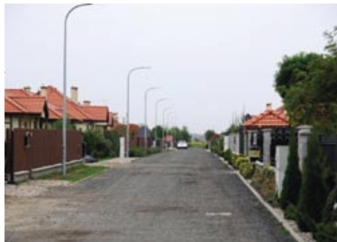
ul. Stokrotki pierwsze oświetlenie drogowe wybudowane w technologii LED na terenie Gminy Serock
