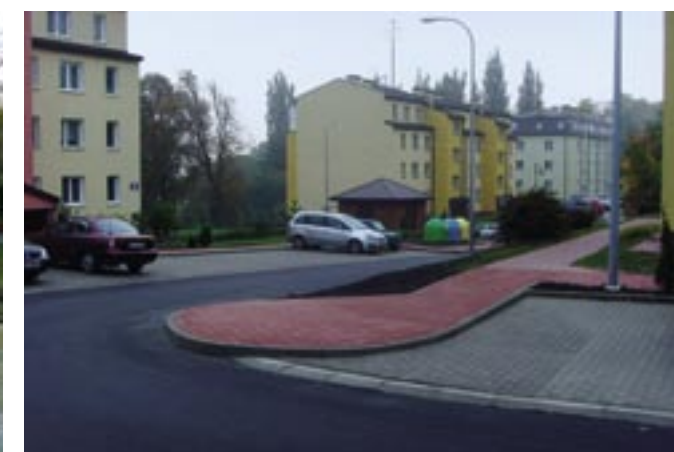
Przebudowa drogi wraz z budową parkingu w Zegrzu przy ul. Drewnowskiego
