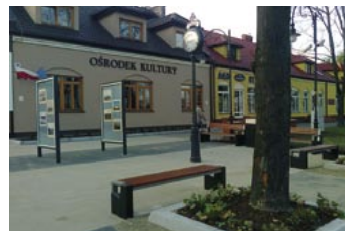
Rozbudowa Ośrodka Kultury w Serocku
