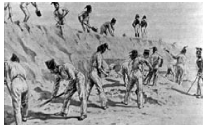
Budowa wałów twierdzy
