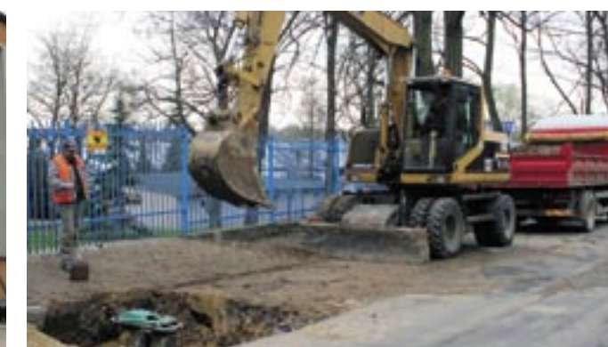
Przebudowa sieci wodociągowej w Zegrzu
