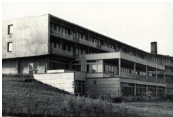
Ośrodek Narew wschodnia elewacja
