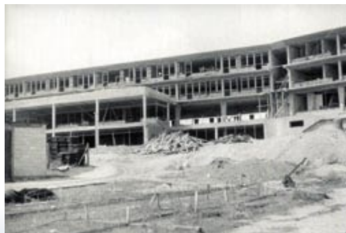
Ośrodek Narew w trakcie budowy
