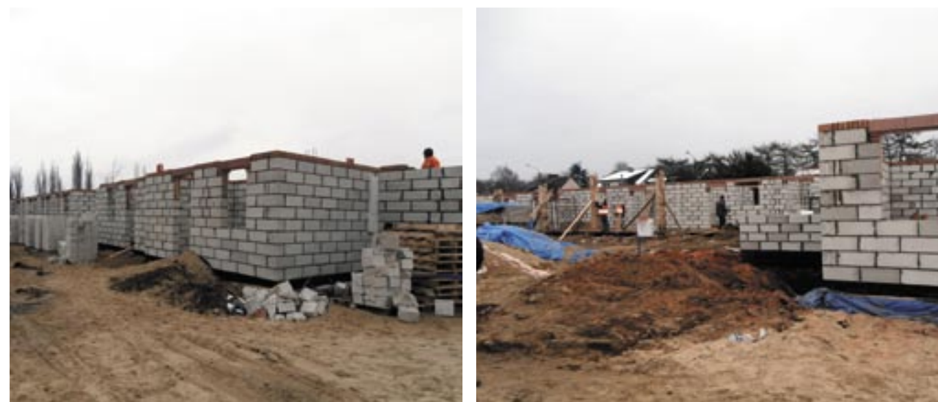
Budowa budynku wielorodzinnego z mieszkaniami socjalnymi w Jadwisinie
