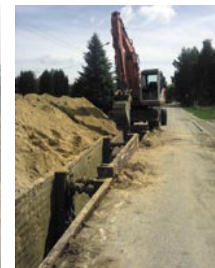
Budowa kanału grawitacyjnego w ulicy Długiej
