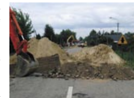
Budowa przejść poprzecznych przez ulicę Nasielską
