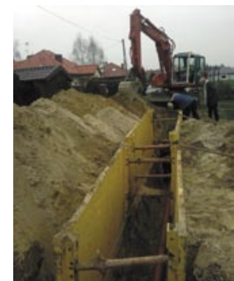
Budowa kanału grawitacyjnego w ulicy Dzikiej Róży
